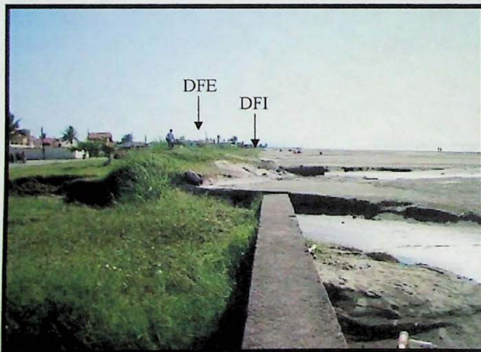
Figura 8: Fotografia tomada sentido NE no término do muro beira-mar (aproximadamente 7 km a NE do rio Peruíbe). Notar que este muro foi construído à frente da DFI.
